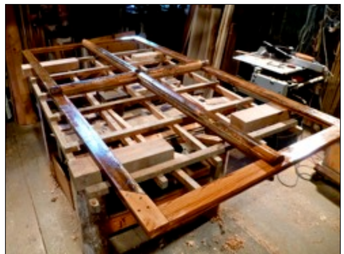
Nach Entfernung aller substanzschädigenden Beschichtungen und nach Holzreparaturen (mit historischem Holz) an diesem Blendrahmen eines Kreuzstockfensters von 1776 wurde die ursprüngliche Konservierung mit rohem und gekochtem Leinöl wiederhergestellt. Im eingebauten Zustand ist die Konservierung nur an den zugänglichen Stellen möglich.
