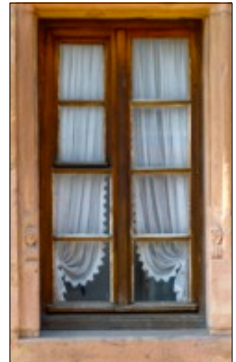
Die Leinölkonservierung an diesem historischen Fenster in Hambach (Neustadt an der Weinstraße) wurde ein halbes Jahrhundert nicht mehr gepflegt. Dennoch hat das Holz keinen Schaden genommen.
