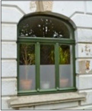
Historisches Fenster mit wiederhergestellter Konservierung mit Leinölfarbe.
