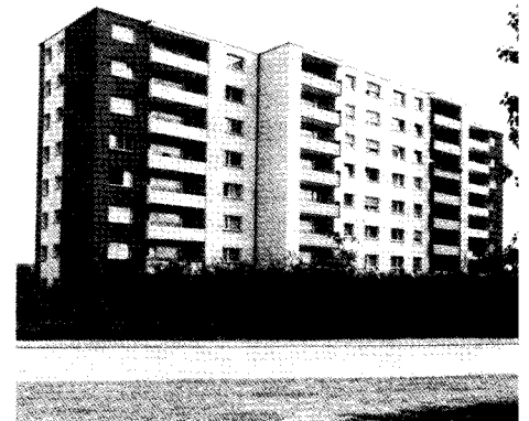
Gebäude C, Emslandstraße 1
