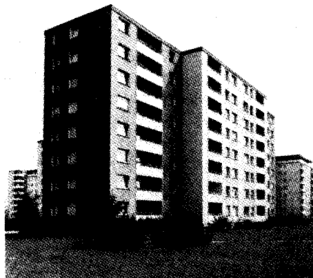
Gebäude B, Am alten Sportplatz 17a
